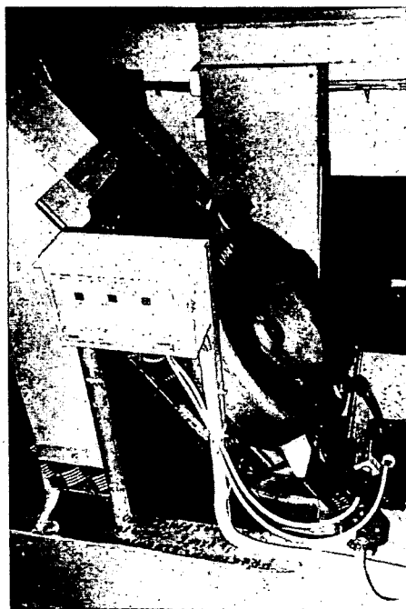
Рис. 5.5. Канатный тормоз (BODE Aufzuge)
